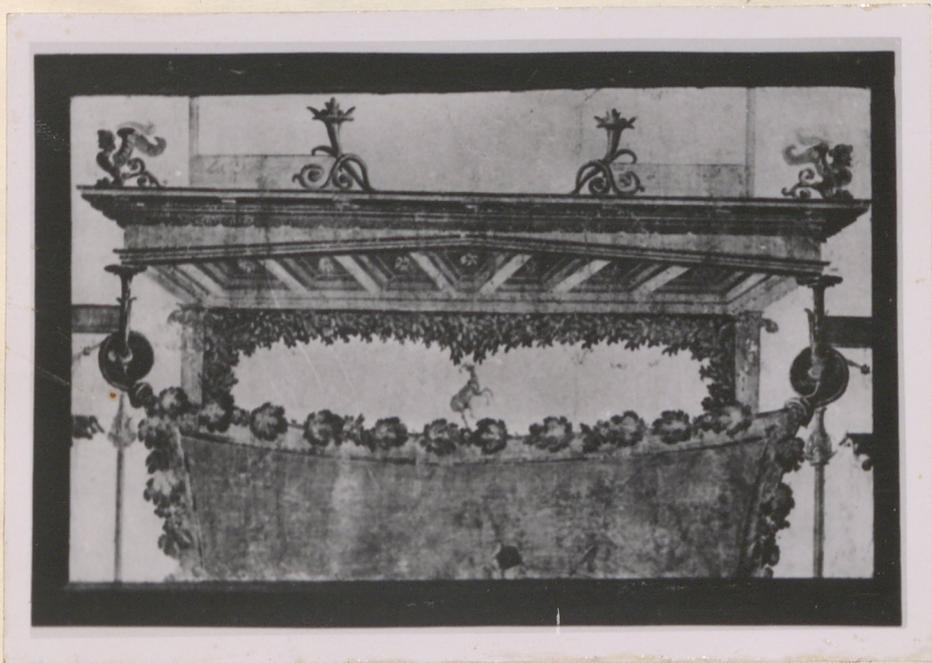
Due aste metalliche sostengono una specie di architrave. A ciascuna asta è applicata un congegno consistente in un disco che termina con tubo nei quali sono infilati i lembi di una cortina. Il congegno doveva servire ad alzare e abbassare la medesima.
