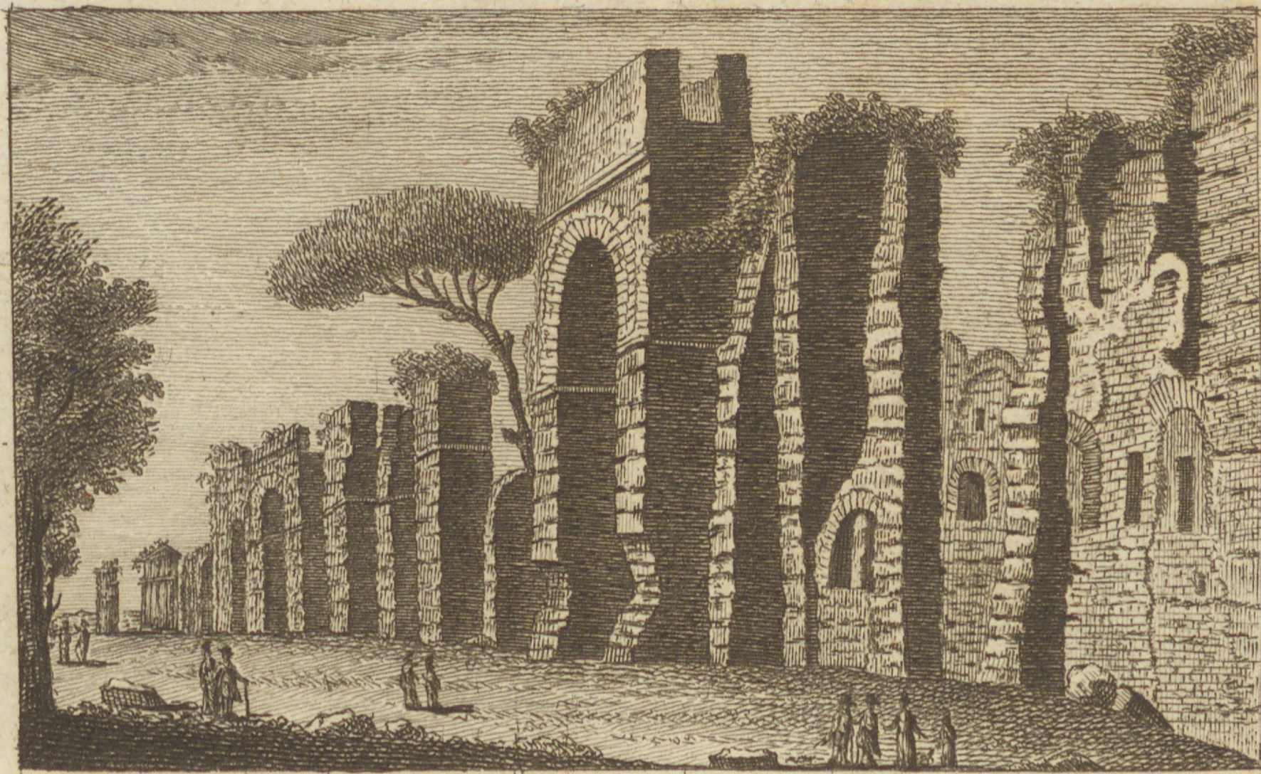
Acquedotto di Nerone || Aqueduc de Nerone
